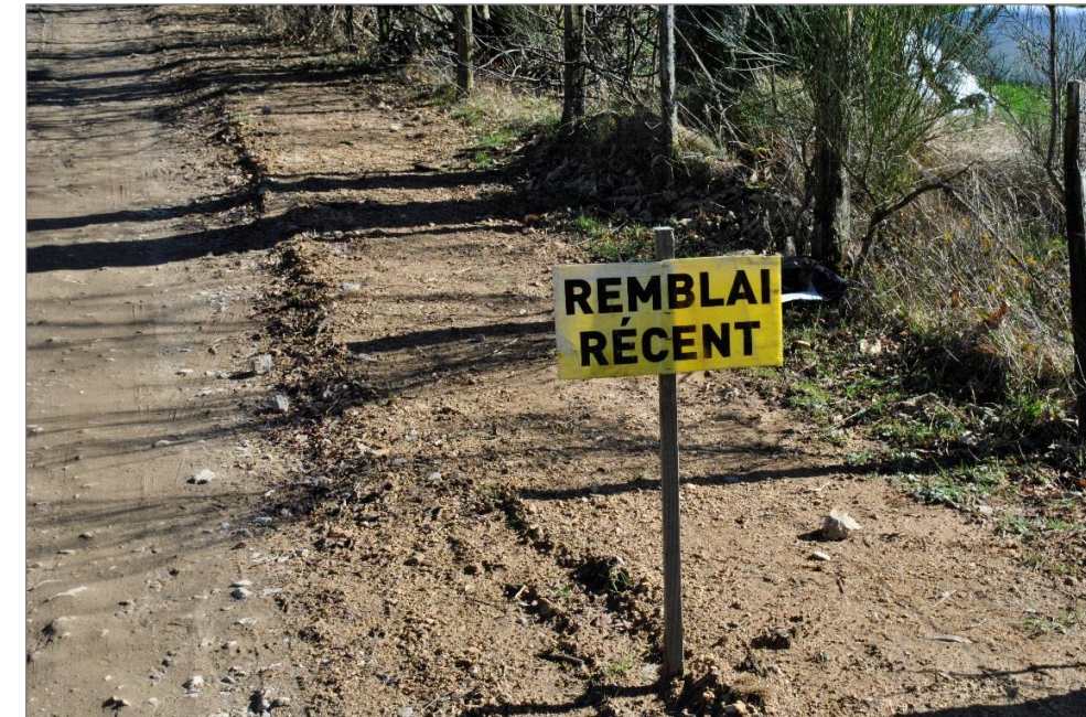
Photographie 42 : Exemple de remblai des tranchées électriques le long d'une piste (Source : ENCIS Environnement)
