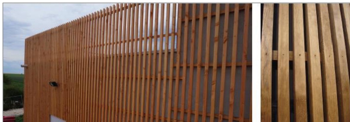
Figure 27 : Exemple du rendu prévu du bardage à claire-voie du poste de livraison (source : ENCIS Environnement)
