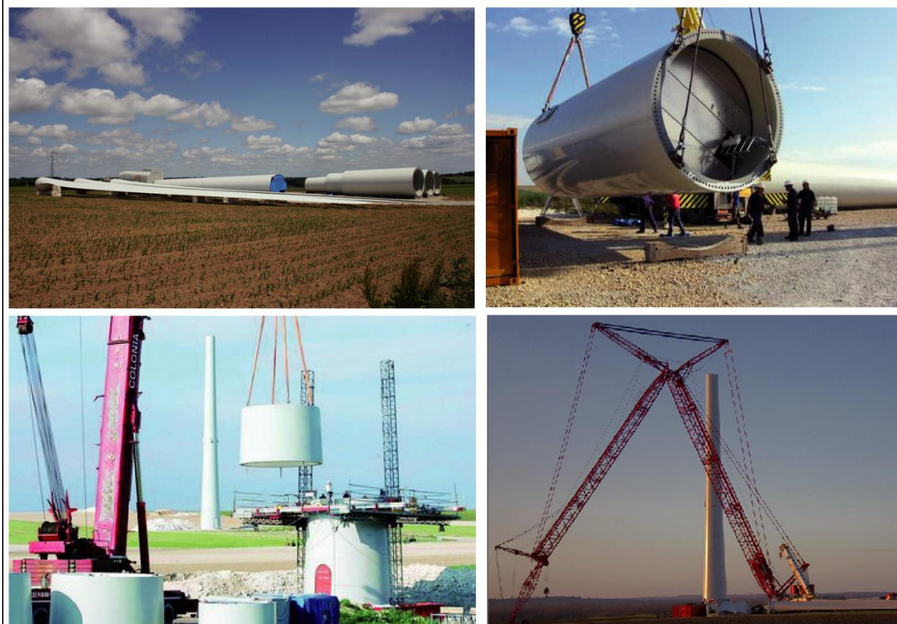
Montage d'une éolienne
